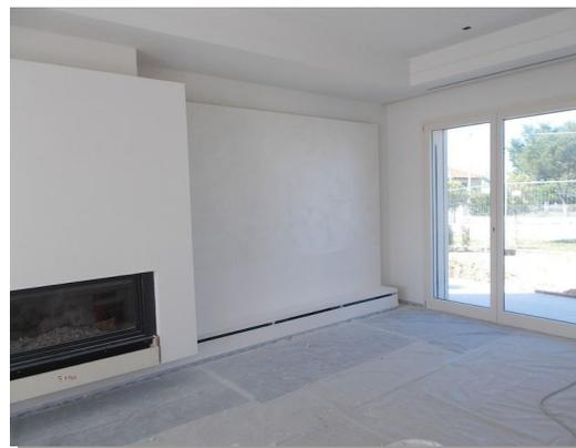
Preparazione delle pareti previa rasatura e stuccatura, successivamente viene dato uno strato di imprimitura e due mani di idropittura traspirante, date a pennello o a rullo, ad una tonalità di colore.
