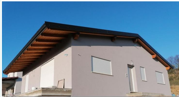
Le finestre sono dotate di avvolgibili coibentati in alluminio con telaio perimetrale.
