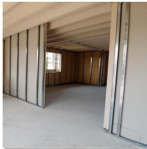
Le pareti divisorie saranno realizzate in cartongesso con supporto su struttura metallica composte da guide a U in acciaio zincato poste su pavimento, con taglio acustico alla base e a soffitto, sulle quali vengono installati i montanti con profilo a C in acciaio zincato posti ad interasse di c. 60 ca, ai quali si fisseranno i pannelli a secco in cartongesso.
