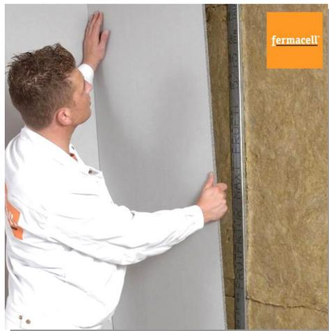
Le lastre in gessofibra vengono impiegate per il rivestimento interno delle strutture in legno. Sono composte all'80% di gesso e al 20% di cellulosa (ottenuta da carta riciclata), senza additivi leganti o idraulicizzanti.
